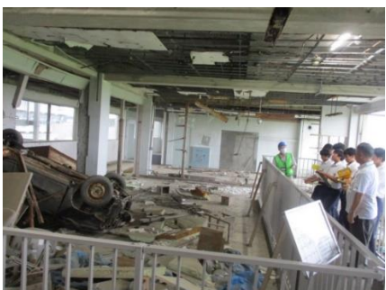
【東日本大震災遺構・校舎内】
